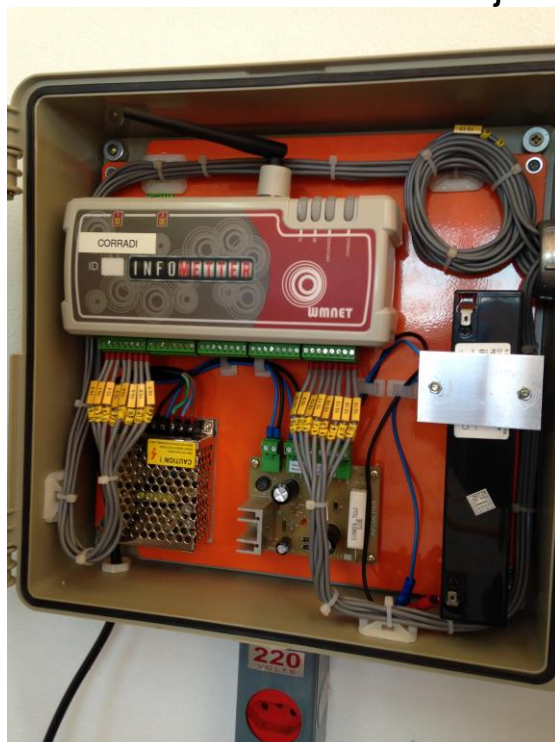
Foto interna do sistema de telemetria.
