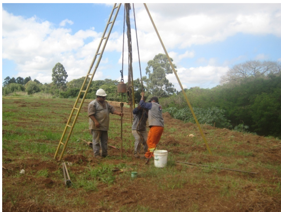
Figura 24 – Execução dos serviços de sondagem a trado para reconhecimento do maciço de resíduos.
