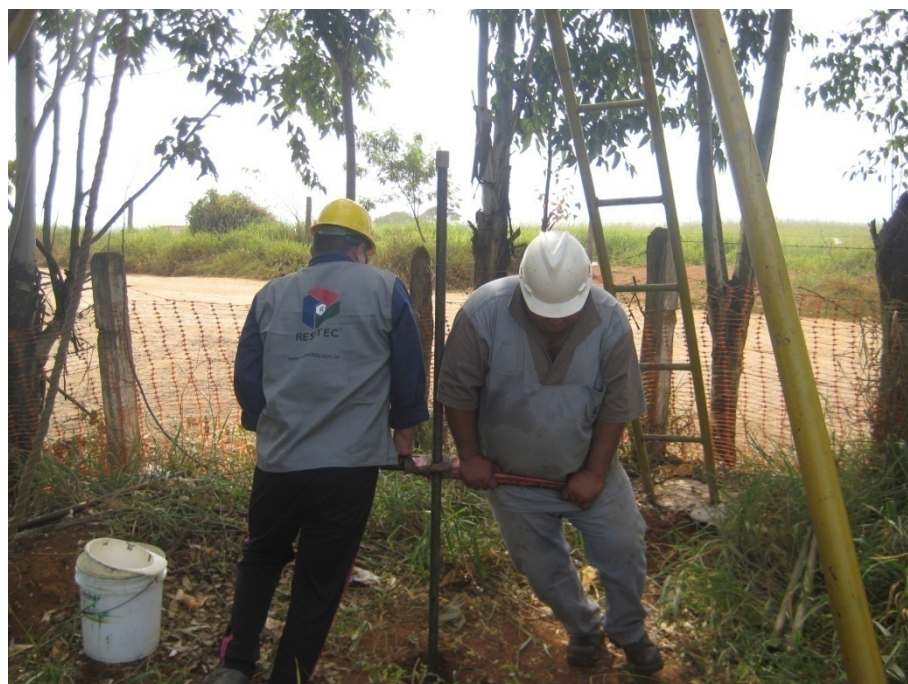
Figura 28 – Execução da sondagem manual através de trado.
