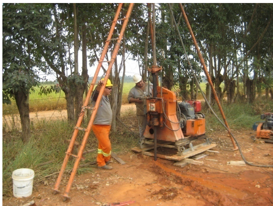
Figura 29 – Execução da sondagem mecanizada através de sonda rotativa.
