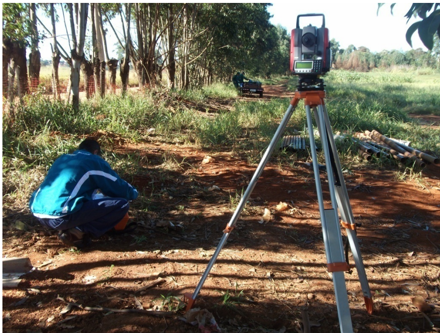
Figura 22 – Utilização de Estação Total para nivelamento topográfico.
