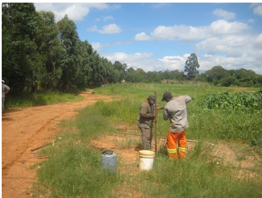
Figura 23 – Início dos serviços de sondagem de reconhecimento no local.
