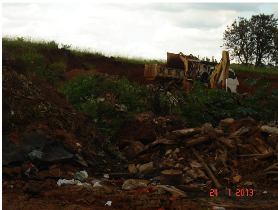
Figura 1 – Observa-se a operação de máquinas no período de operação do aterro.
