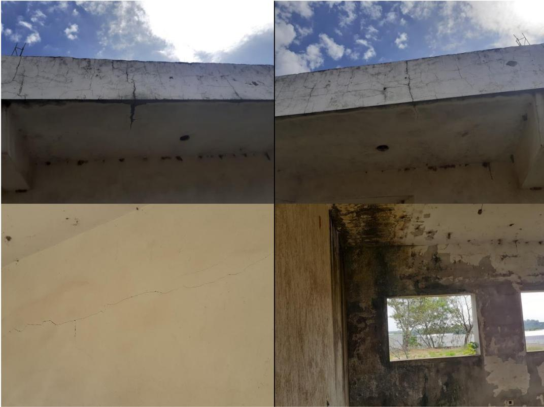
Segue fotos da edificação construída no lote, foi utilizado na construção treliça como colunas e aparentemente como vigamento. Há visivelmente rachaduras, trincos, umidade e bolor nas paredes e tetos.
