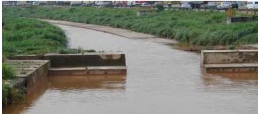
Imagem 12. Soleira na calha do rio Aricanduva (São Paulo, SP).
