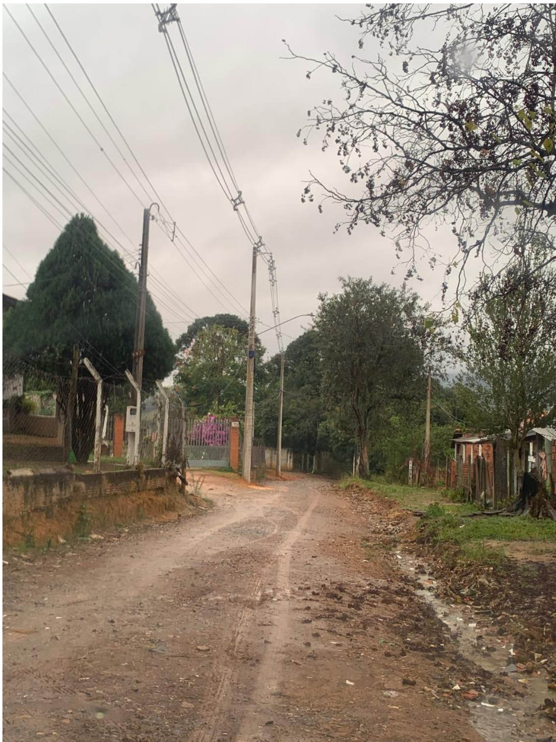
Imagem 7 - Rua sem pavimentação, nem guias, calçadas ou sarjetas. Há uma vala para escoamento de águas pluviais - vista 3.
