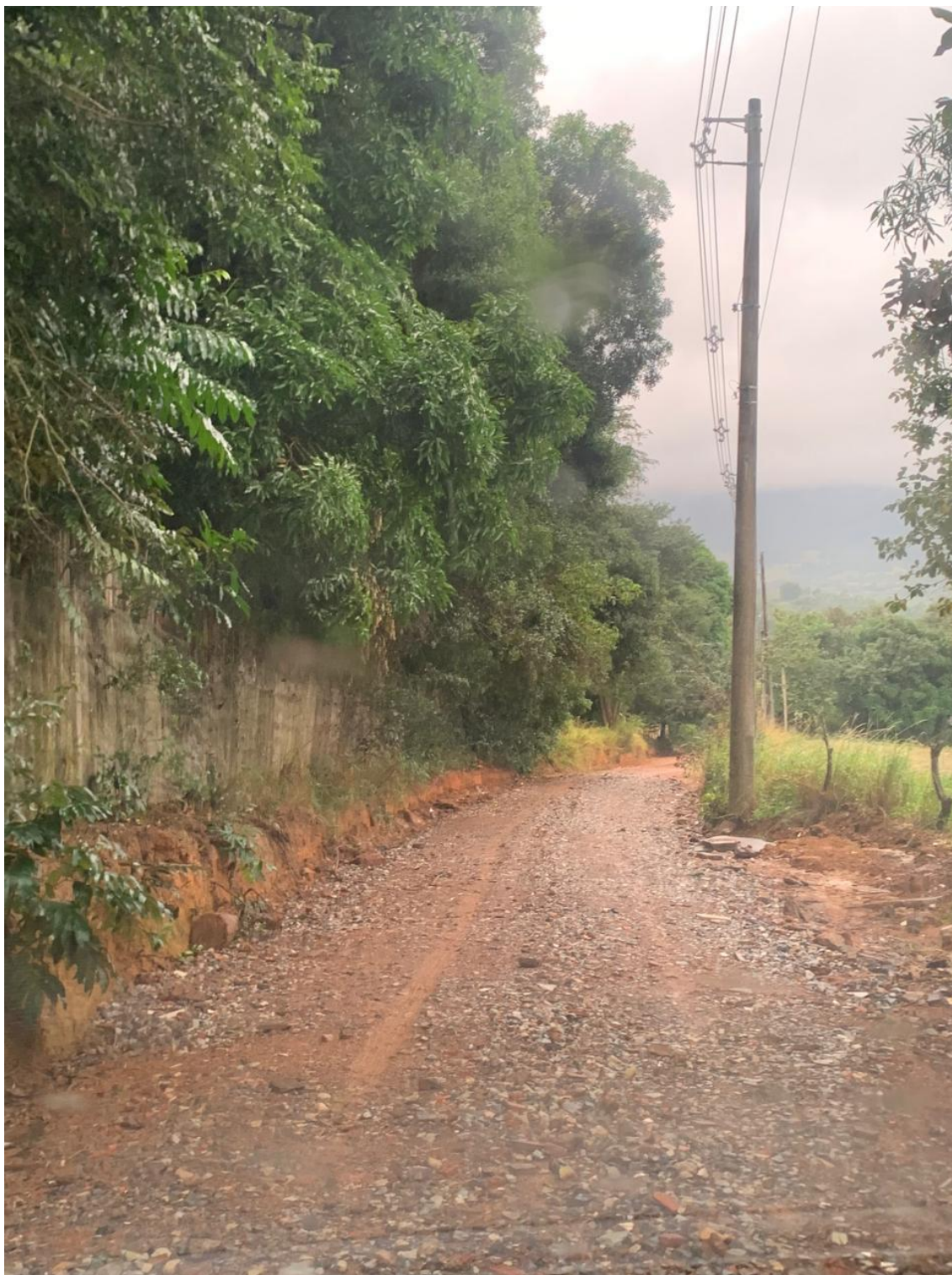
Imagem 8 - Rua sem pavimentação, nem guias, calçadas ou sarjetas. Há uma vala para escoamento de águas pluviais - vista 4.
