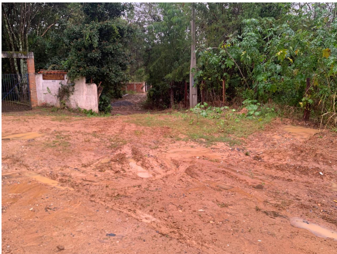
Imagem 11 - Trecho da via com presença de erosão e acúmulo de água – vista 2.
