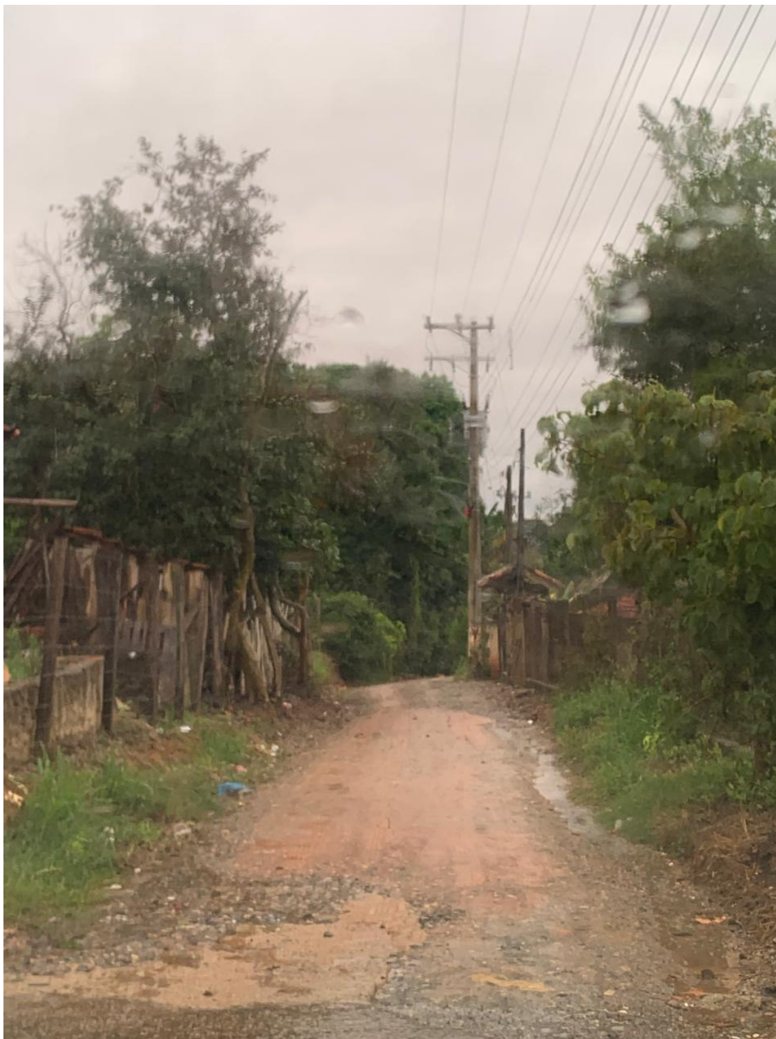
Imagem 5 -Rua sem pavimentação, nem guias, calçadas ou sarjetas. Há uma vala para escoamento de águas pluviais – Vista 1.
