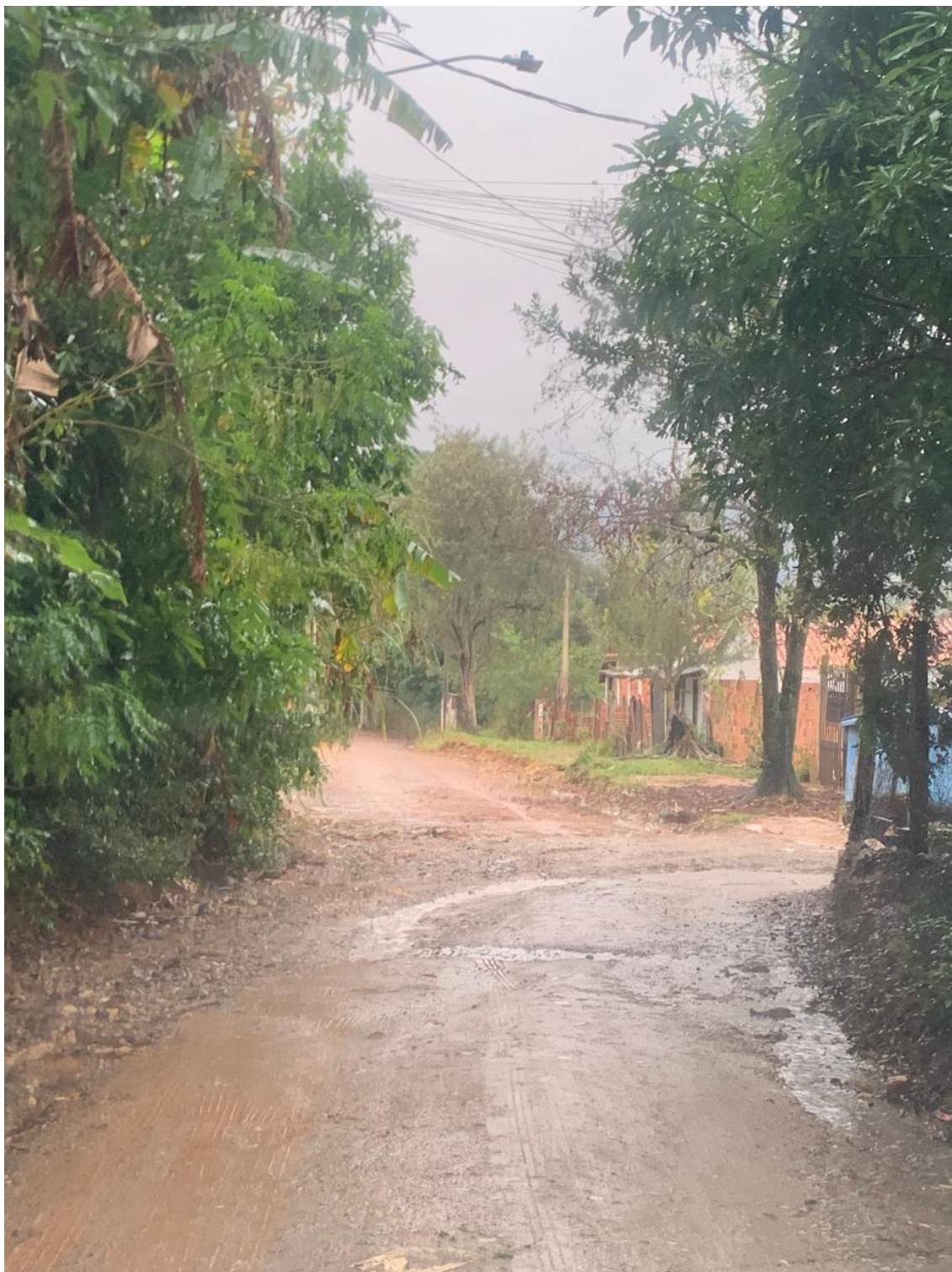
Imagem 6 - Rua sem pavimentação, nem guias, calçadas ou sarjetas. Há uma vala para escoamento de águas pluviais - vista 2.
