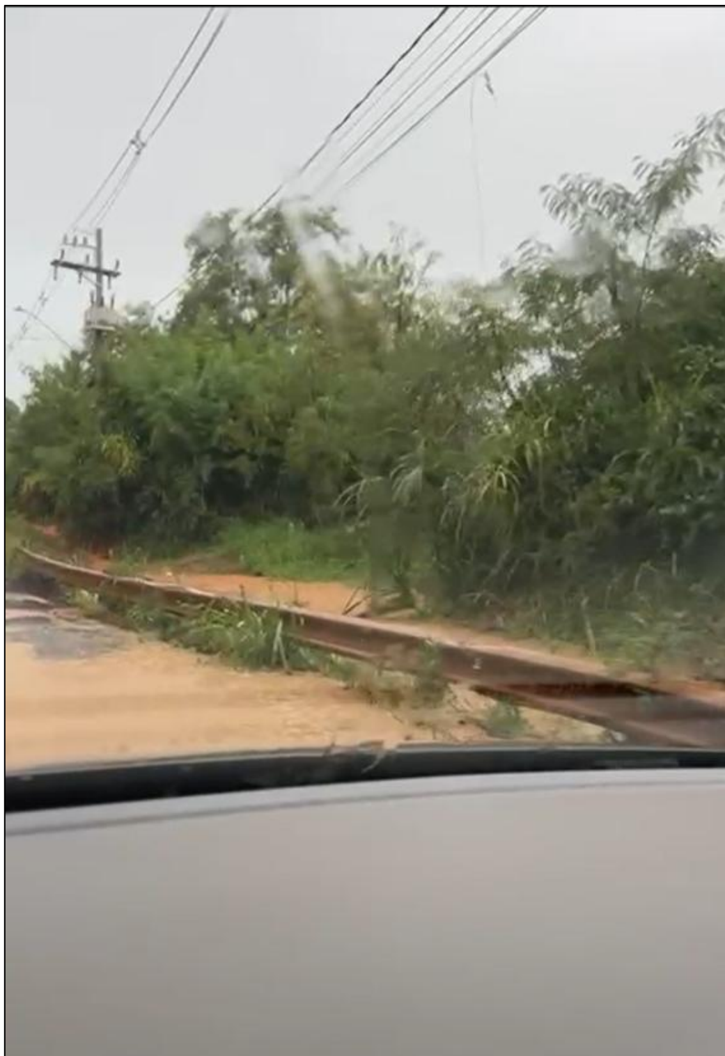
Imagem 11- Ocorrência de alagamento no trecho da travessia – dezembro de 2024 – vista 2.
