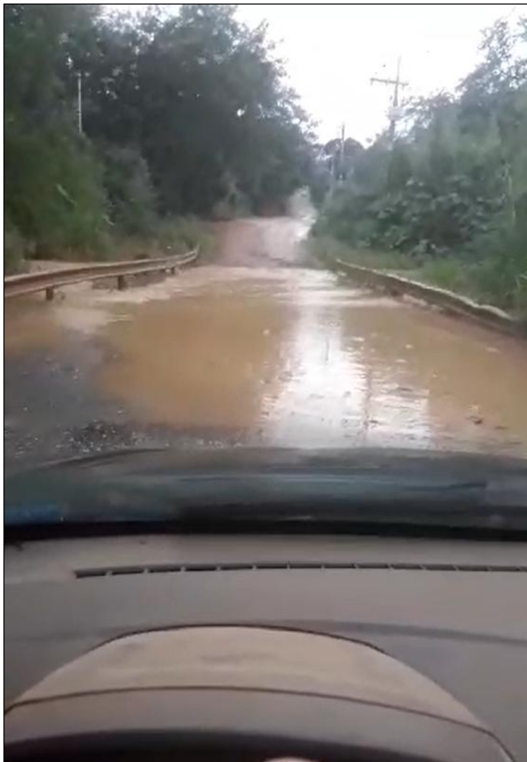
Imagem 8 - Ocorrência de alagamento no trecho da travessia – novembro de 2024.
