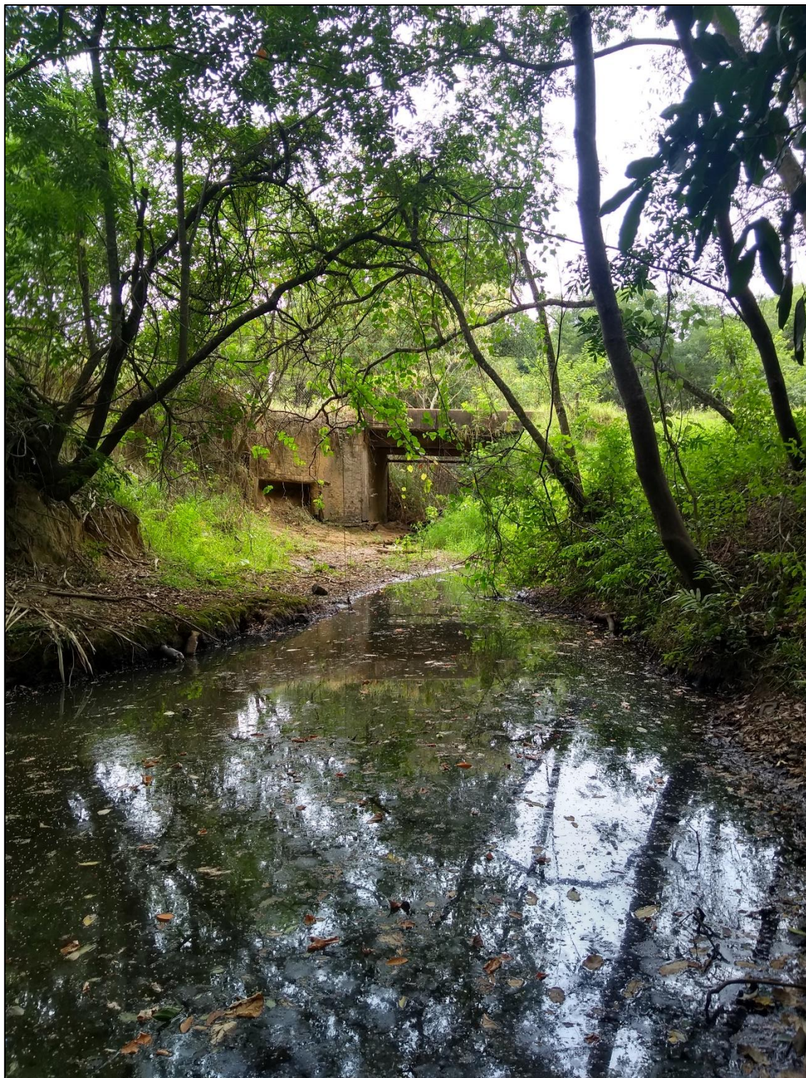
IMAGEM 3 - Trecho do Rio Iperó com sinais de assoreamento – vista 1.
