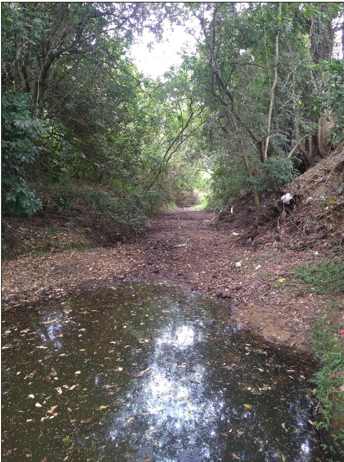
IMAGEM 4 – Trecho do Rio Iperó com sinais de assoreamento – vista 2.
