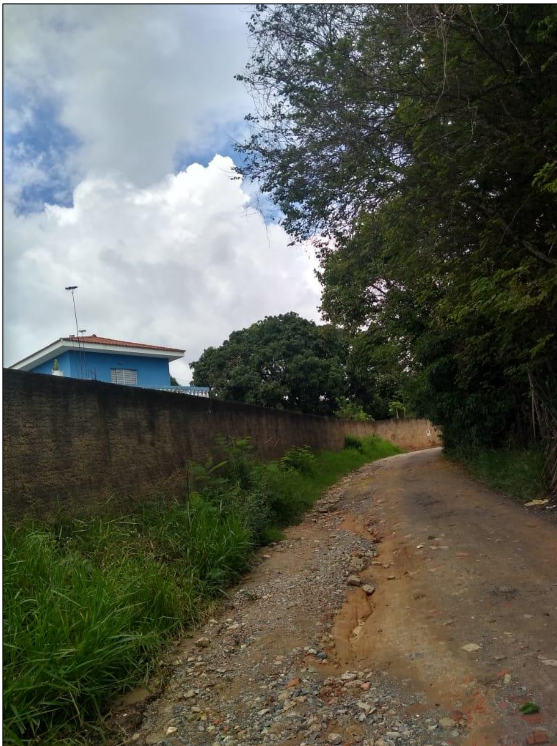
IMAGEM 10 - Rua sem pavimentação, nem guias, calçadas ou sarjetas. Há uma vala para escoamento de águas pluviais.
