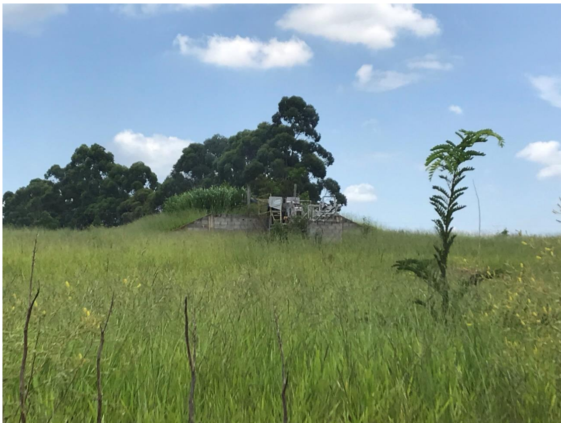
Figura 6-12 Unidade de triagem de RCC desativada Fonte: CONSÓRCIO CM (2021)
