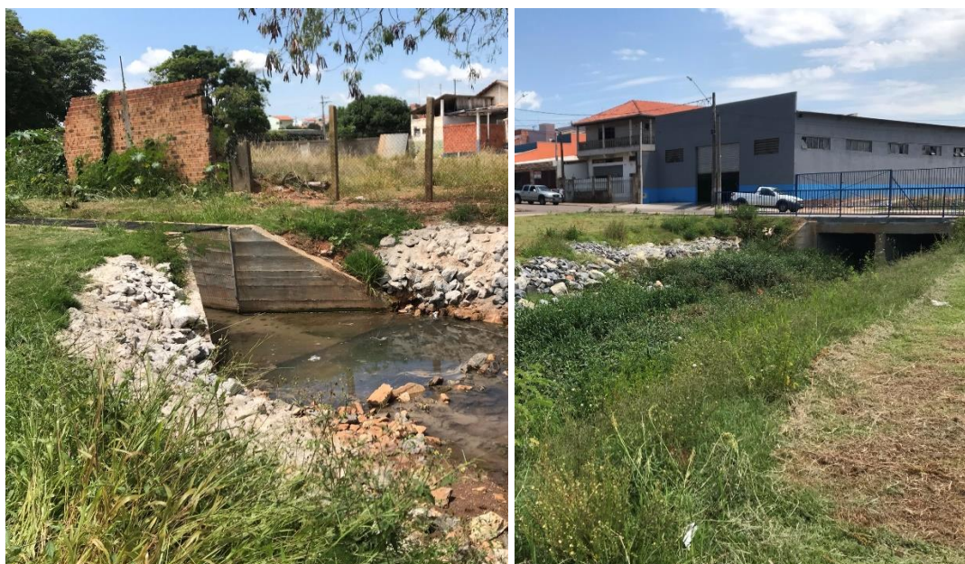
Figura 7-7 - Canalização, adequação de calha e travessia no Córrego da Olaria Fonte: CONSÓRCIO CM (2021)
