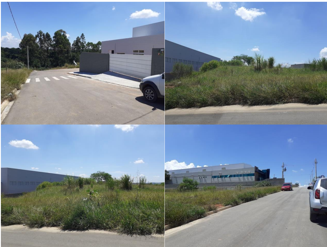
Notam-se os melhoramentos públicos existentes na via.
