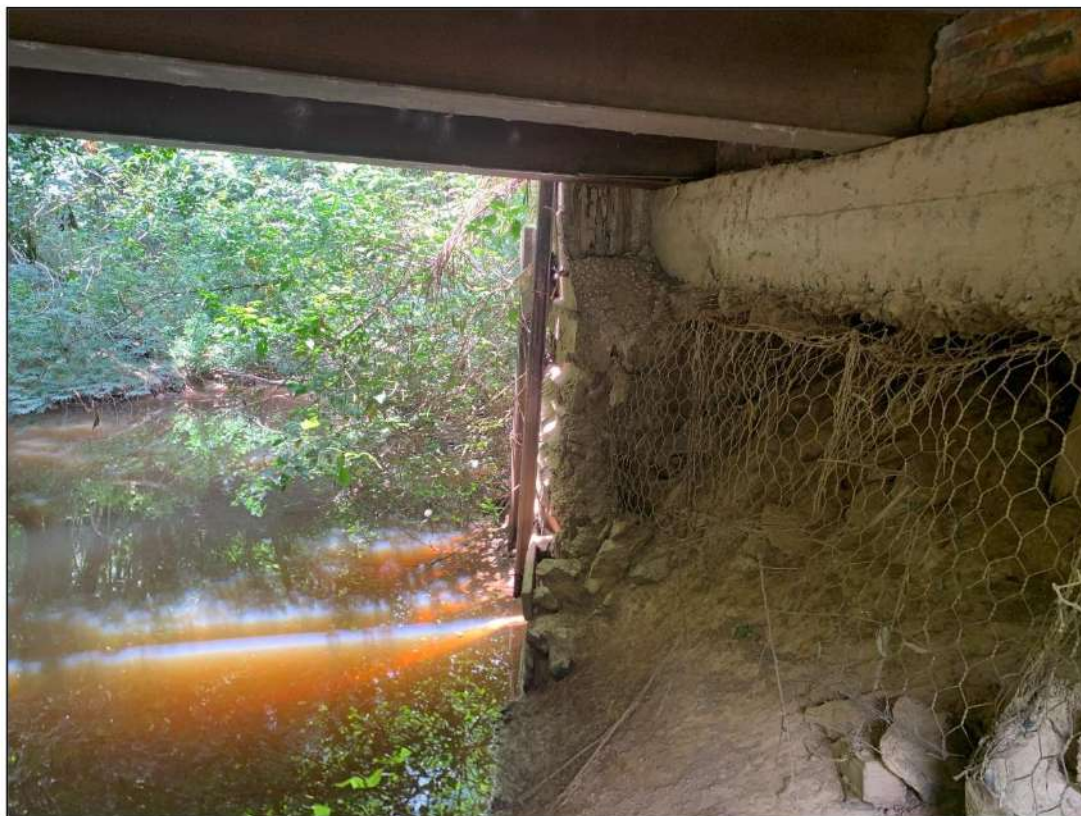
Imagem 17 - Travessia Rio Iperó - Vista inferior 5 – Montante.
