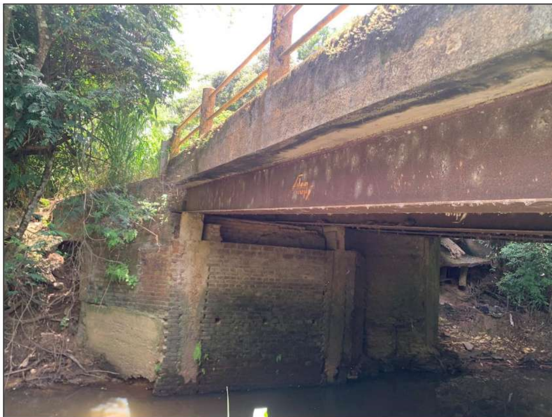
Imagem 13 - Travessia Rio Iperó - Vista inferior 1 – Jusante.
