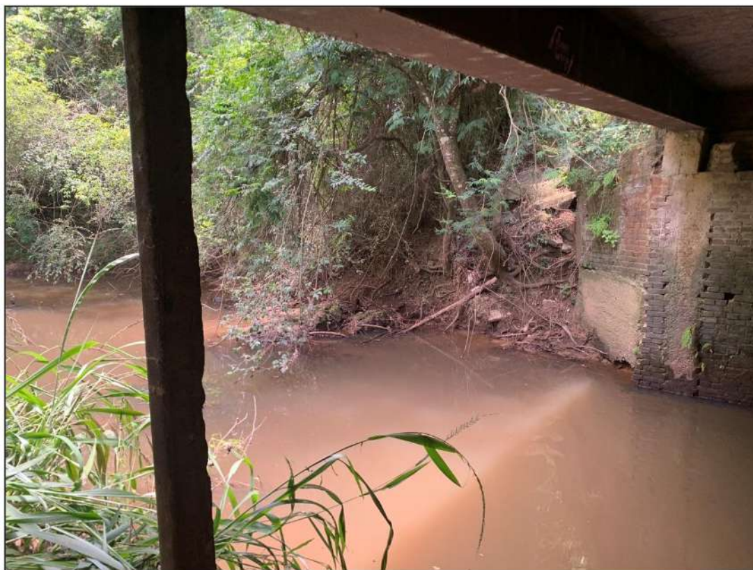
Imagem 14 - Travessia Rio Iperó - Vista inferior 2 – Jusante.
