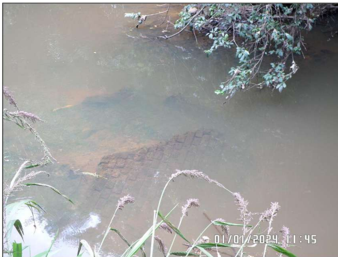
Imagem 20 - Parte do muro ala submerso no Rio Iperó.
