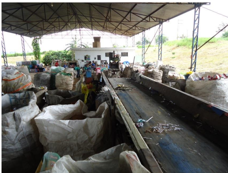
Foto 4 – Esteira para triagem de resíduos
