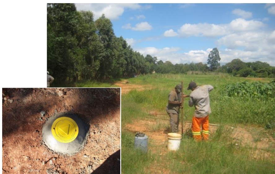
Foto 36 – Realização de poços de monitoramento.
