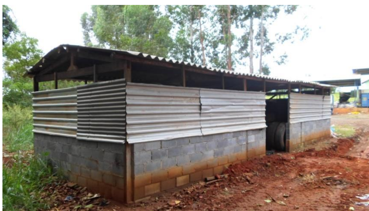
Foto 23 – Barracão para recebimento de pneus inservíveis
